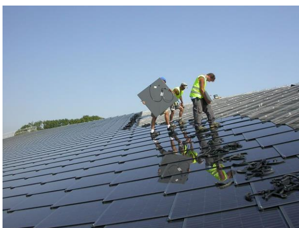
Obrázek 2.5-1: Instalace solárních tašek firmy SUNSTYLE [12]
