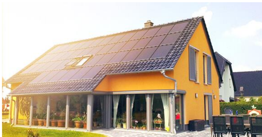
Obrázek 2.6-1: FV moduly integrované ve střeše firmy Solarwatt [13]
